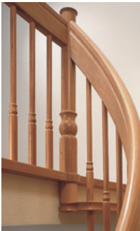
(B.13) Geländerstäbe an einer Treppe (Treppenmeister)
