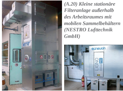
(A.21 – kl. Bild) Kleine stationäre Filteranlage, die in Innenräumen installiert werden kann. (Firma Scheuch GmbH)
