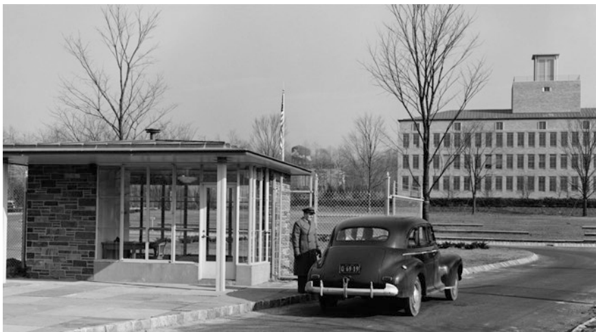
Abb. 1.2 Die Einfahrt zu den Bell-Laboratorien in New Jersey, USA, etwa 1943. (© Library of Congress, Gottscho-Schleisner Collection)
