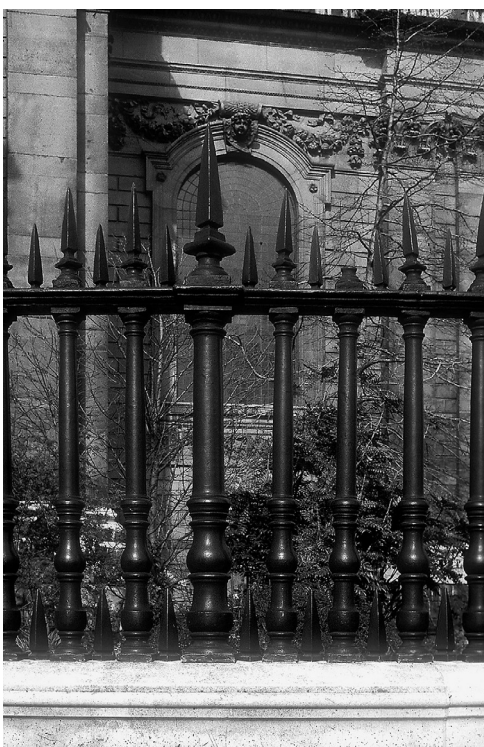
1.2. Rejas de hierro forjado que rodean la catedral de San Pablo, Londres, 1714, construida por Christopher Wren. (Fotografía del autor.)
