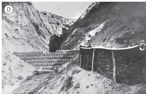
**Fig. 1.3** Primera patente del gavión metálico (A), fotos históricas de Italia en 1910 (B) y 1923 (C), y en Etiopía en 1937 (D)
