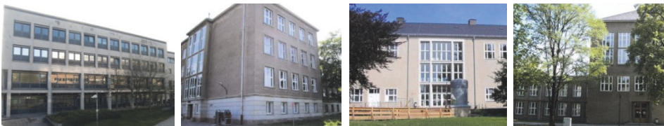
Bild 3-1 Betrachtete Campusgebäude GER, WILL, TRE, REC (v.l.n.r.).
