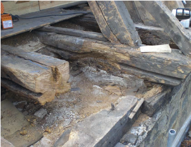
Bild 2-2 Feuchtigkeit und Pilzbefall haben dem historischen Gebälk vor allem im Traufbereich stark zugesetzt (Foto: © Eifert Holzbau GmbH).
