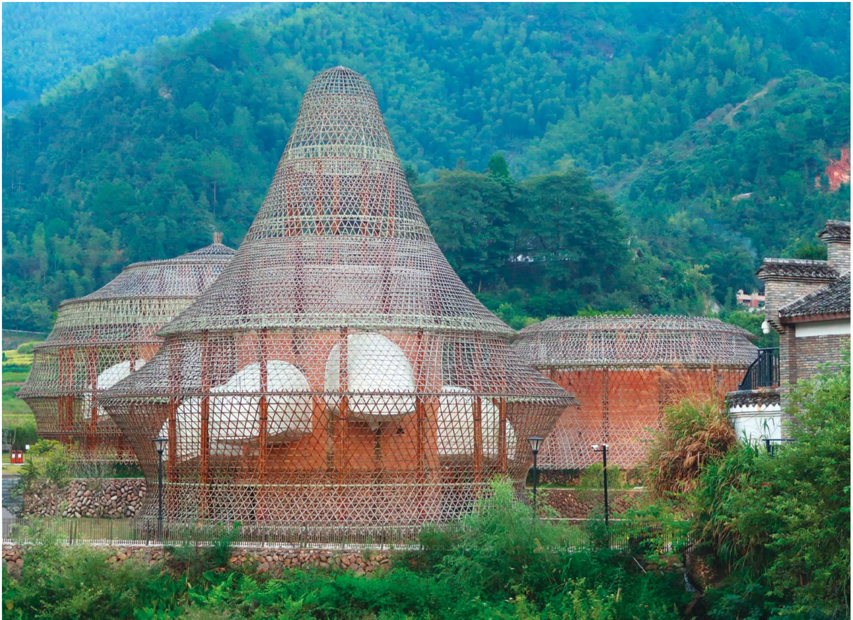
Gästehaus, gebaut aus grossen Kieselsteinen, Stampflehm und Bambus in Baoxi, China, 2016.
