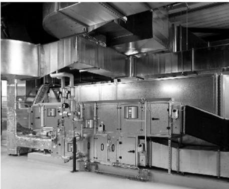
**Bild 1.1** Lüftungsanlage in einem Zweckbau [ABB]
