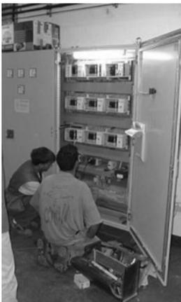
**Bild 1.9** Klemmleiste und DDC-Bausteine im Schaltschrank [ABB]
