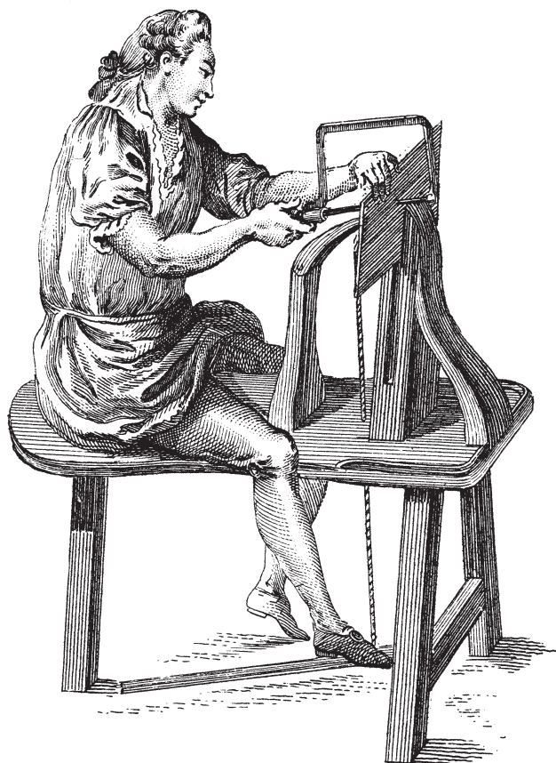
Die Abbildung aus einer frühen französischen Enzyklopädie um 1774 zeigt einen „Ebenisten“ bei der Arbeit mit der Laubsäge
