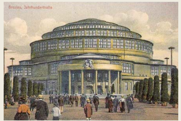
Breslau, Stadt: Die Jahrhunderthalle in Breslau entstand zwischen 1911 und 1913 nach den Plänen des Architekten Max Berg. Mit einer freien Spannweite von 65 m Durchmesser war die Kuppel damals weltweit die größte dieser Art.
