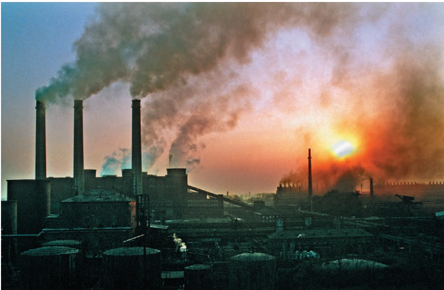
Abb. 4.1: Ein Braunkohlekraftwerk mit kaum übersehbarem Schadstoffausstoß, wie es vielfach in Osteuropa zu finden ist; konventionelle Großkraftwerke wandeln die eingesetzte Primärenergie nur zu 35 % bis 40 % in elektrische Energie um. Hinzu kommen die Leitungsverluste der Überlandleitungen. (Foto: BSW-Solar/Langrock)
