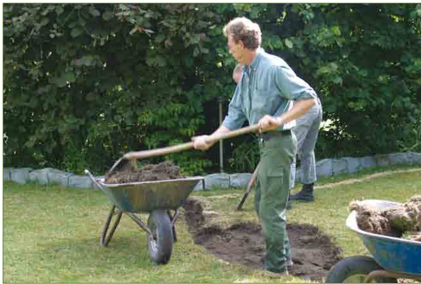
Abb. 3.3 – Rasensoden und Oberboden abtragen. Quelle (1).
