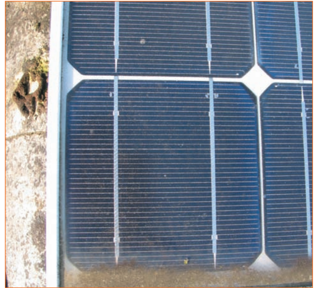
Abb. 11 – Verschmutzung einer Solaranlage (Photovoltaikmodul) durch ungenügende Neigung (12°).
