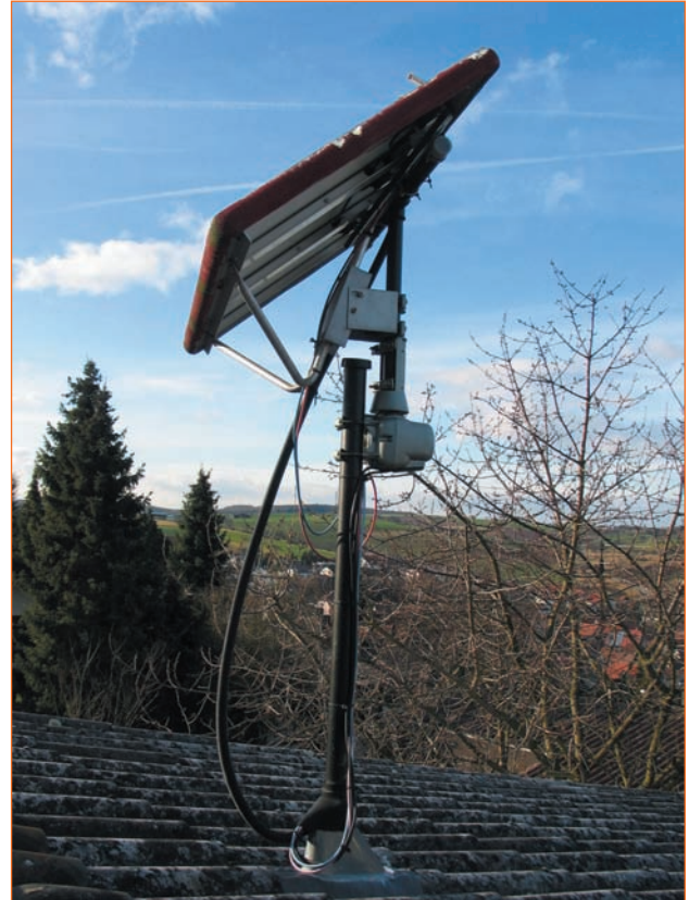
Abb. 75 – Befestigung mit Satellitenteilen, vom Schrott oder gekauft, bestens geeignet, um die Module zu montieren. Die Winkelverstellung für den Neigungswinkel des Solargenerators wird gleich exklusiv dazu geliefert.
