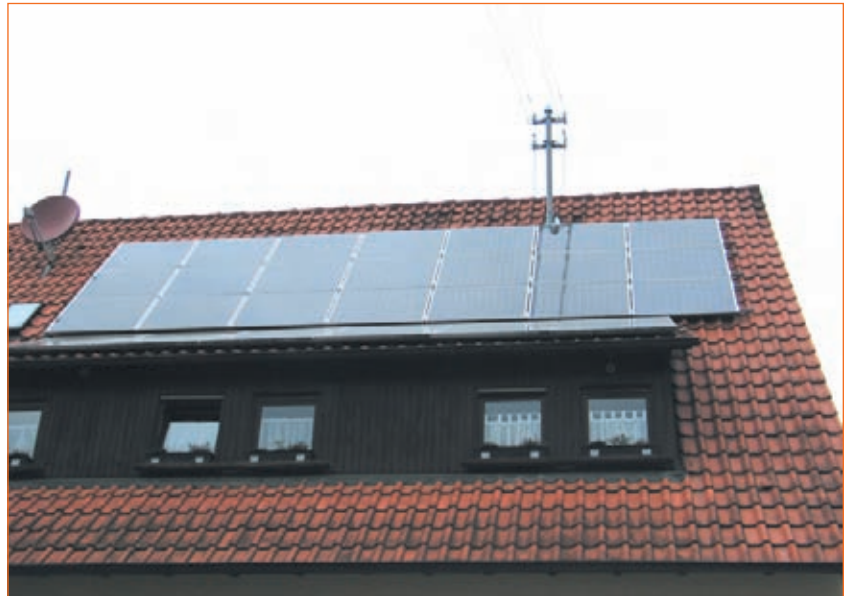
Abb. 1 – Photovoltaik im Altbau.
