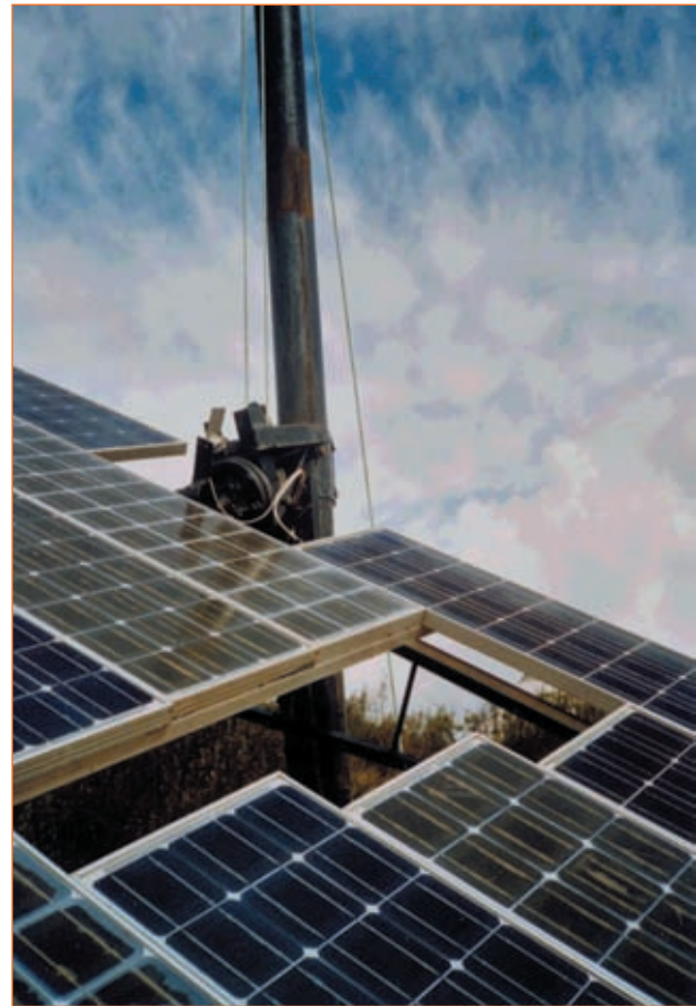
Abb. 71 – Jahreszeitliche Winkelverstellung durch eine Kippvorrichtung und den Seilzug.
