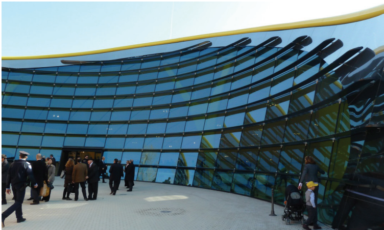
Bild 3-1 Glasfassade, Sicht von außen
