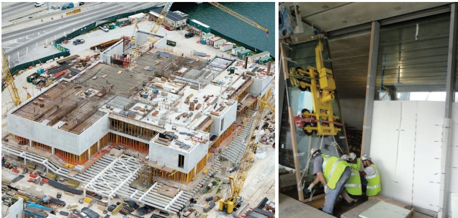
Bild 2-1 Pérez Art Museum Miami – Rohbaufortschritt / Einbau der ersten Scheiben (© seele)
