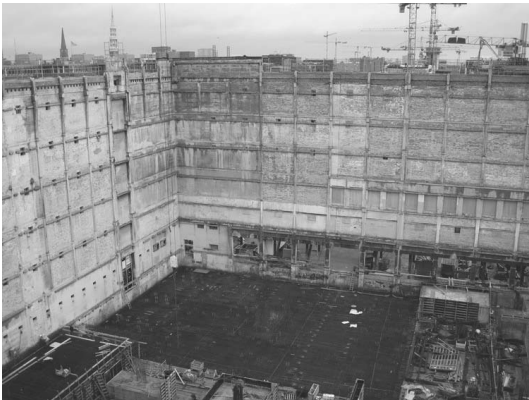
a) Mauerwerkshülle des ehemaligen Kaispeichers A (1965) in Hamburg nach Entfernung des inneren Skeletts
