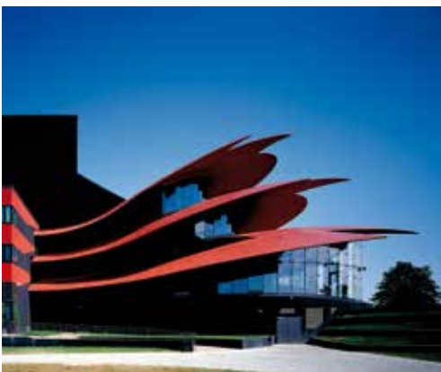
Bild 3.1: Dächer wie Palmenblätter aus Beton mit 45° Neigung; Hans Otto Theater in Potsdam.
