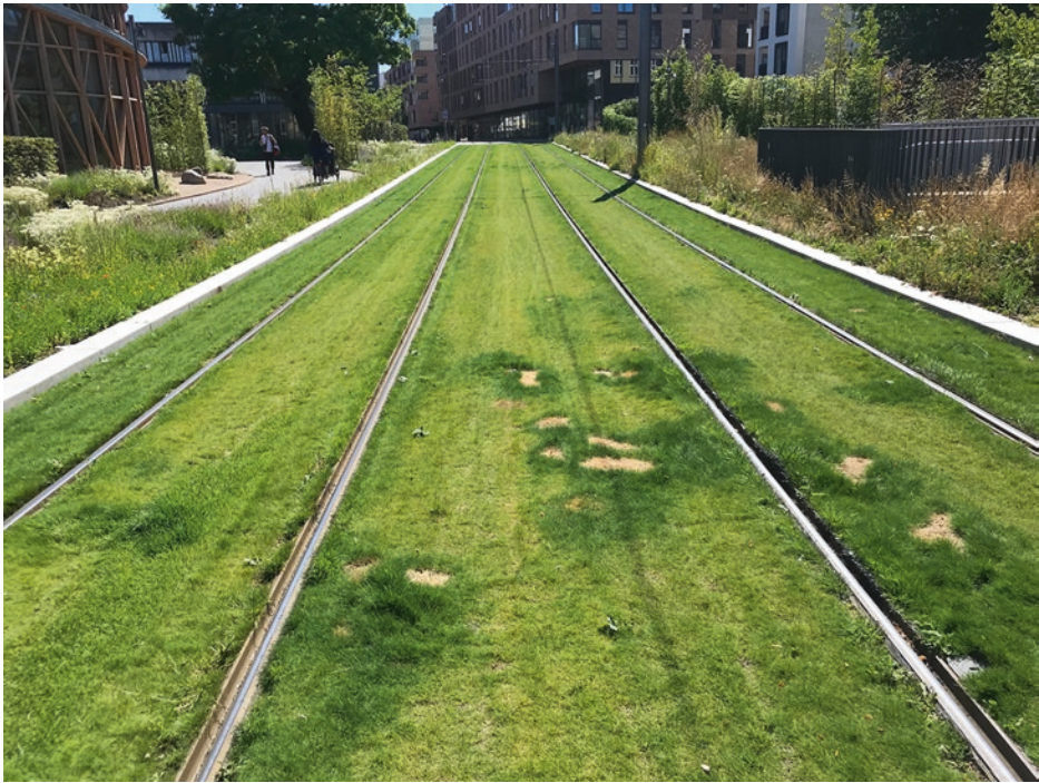
Eine Begrünung, die kühlen kann und den Boden nicht versiegelt: Trambahnschienen in Odense. Foto Jan Grossarth
