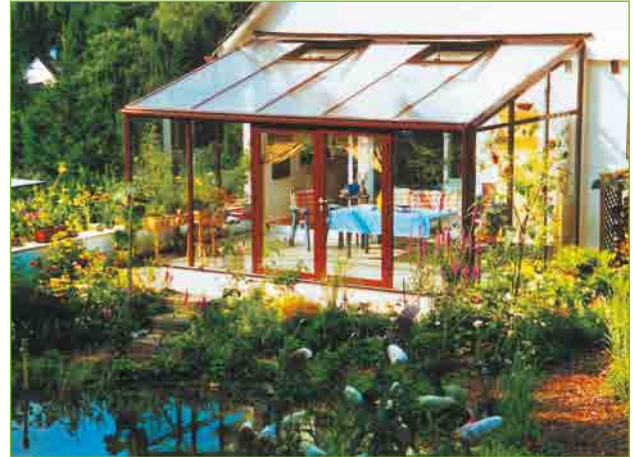
Abb. 3.10 – Entlüftung über die Dachfenster. Quelle [2]
