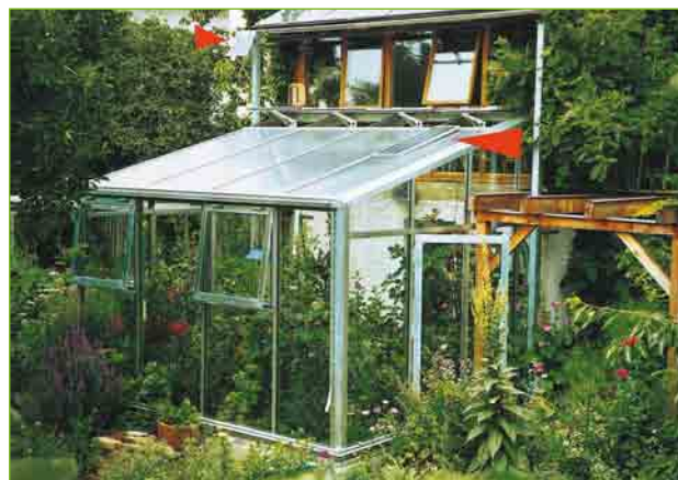
Abb. 3.12 – Mit Sonnenenergie versorgte Lüftung (siehe Pfeile). Quelle [2]
