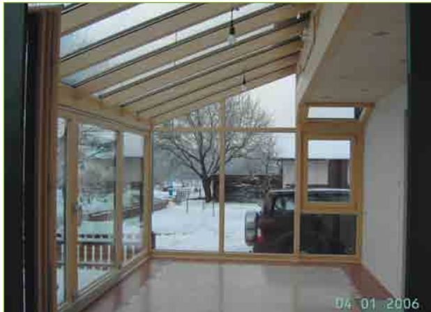
Abb. 3.15 – Unsichtbare Bodenheizung im Wintergarten. Quelle [1]
