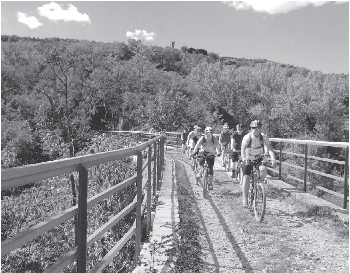
Über eine ehemalige Brücke auf der aufgelassenen Bahntrasse der Parenzana
