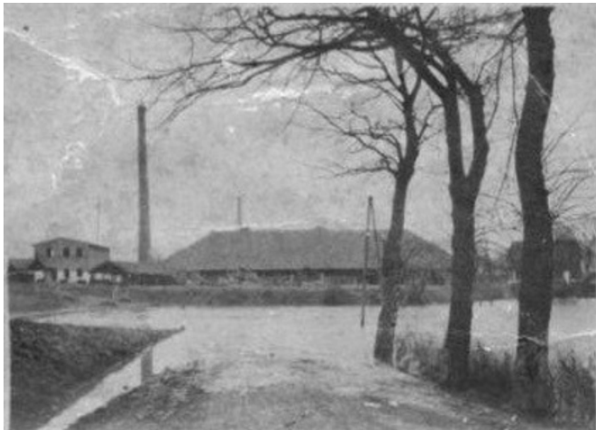
Hochwasser in der Kripper Ziegelei
