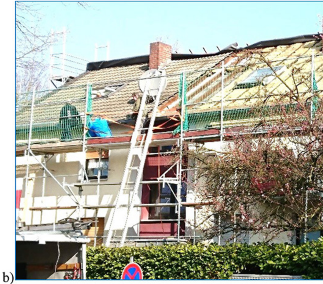
Abb. 1.6: Typische Bauarbeiten während der Instandsetzung von Gebäuden: a – Umbau; b – zusätzliche Wärmedämmung des Dachs
