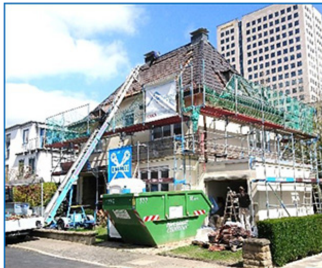
Abb. 1.4: Instandsetzung von Gebäuden
