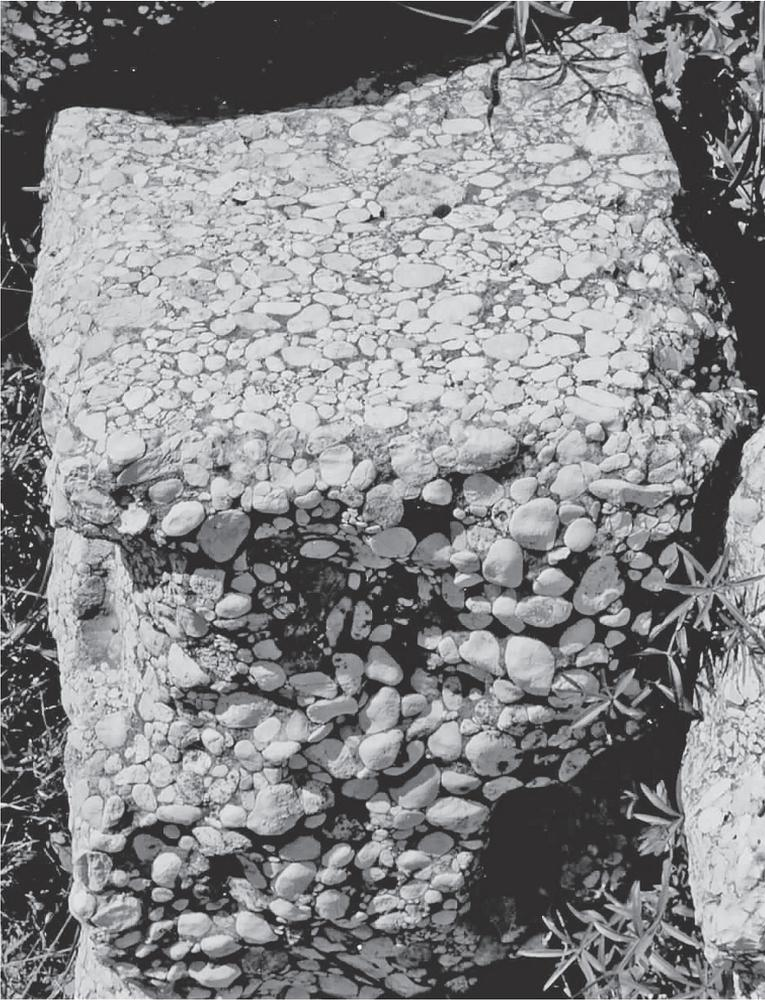
Abb. 2. Bei dem hier anstehenden, zum Straßenbau verwendeten Konglomeratgestein ist Bearbeitung (hier die obere Fläche) schwerer zu erkennen als beim charakteristischen Basaltplaster der anderen römischen Konsularstraßen.
