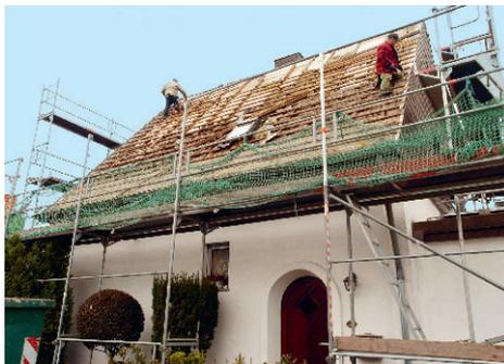
Das Dach wird abgedeckt, um eine Aufsparrendämmung zu installieren.
