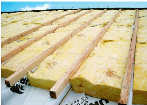
Zwischensparrendämmung eines Satteldachs von außen
