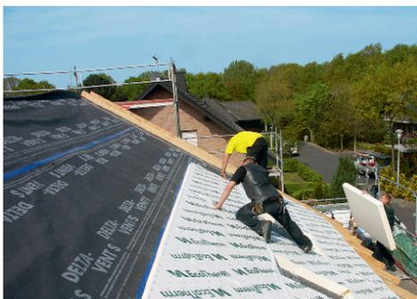
Abschließende Kombination der Dämmung zwischen den Sparren mit einer Aufsparrendämmung
