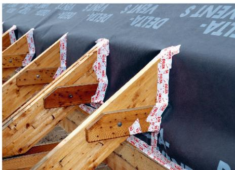
Das luftdichte Abkleben der Dampfbremssolie ist unbedingt erforderlich.
