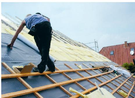
Zwischensparrendeckung mit Folie und Unterkonstruktion für die Dachbekleidung
