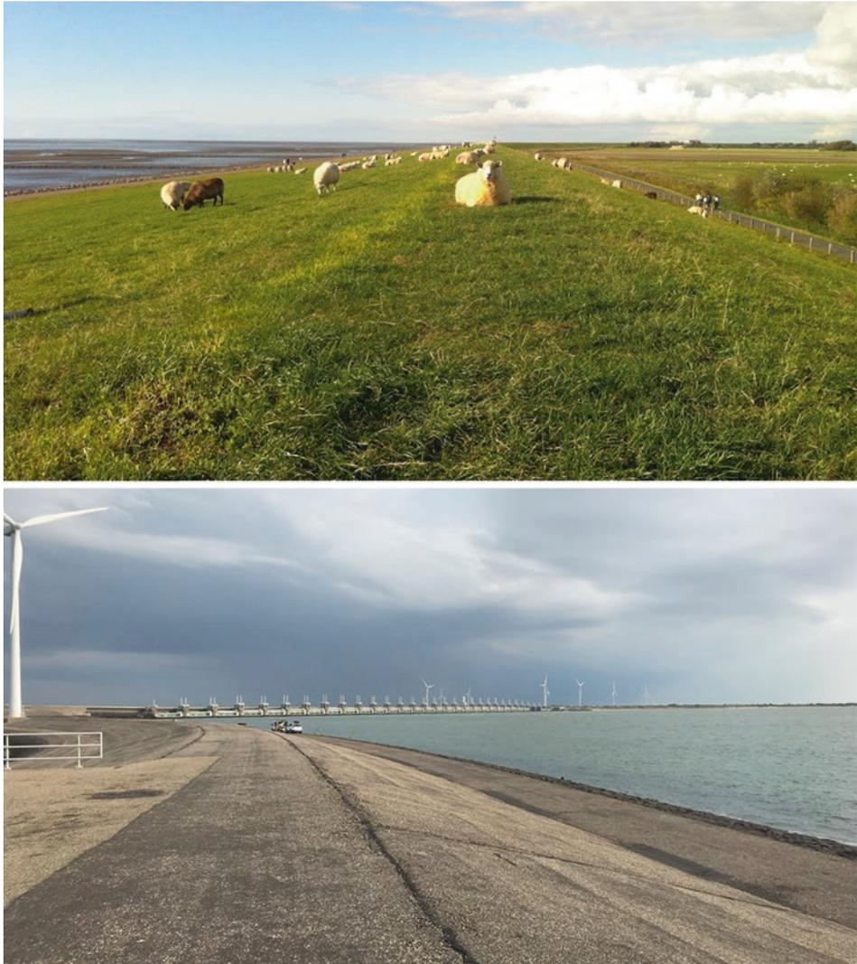
**Abb. 1.1** Seedeich mit Grasdeckschicht (oben, Foto: Schüttrumpf, 2012) und Seedeich mit grauem Deckwerk (unten, Foto: Schüttrumpf, 2019)
